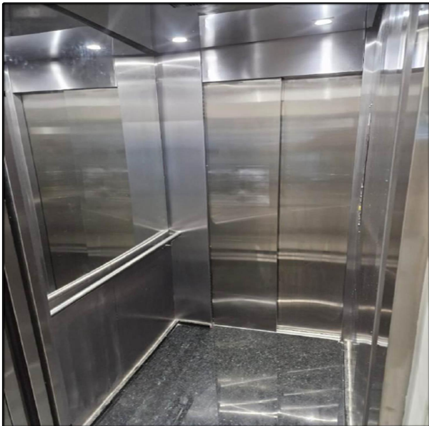
Figura 11 – Elevador área estacionamento, acabamentos internos.
